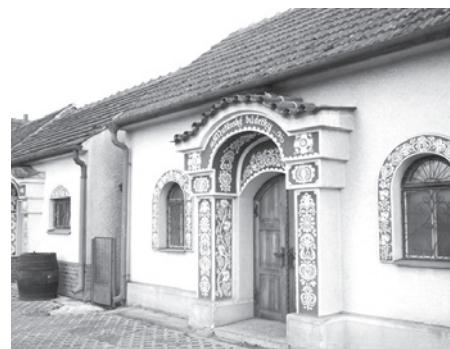
Vinné sklepy v Mutěnicích
